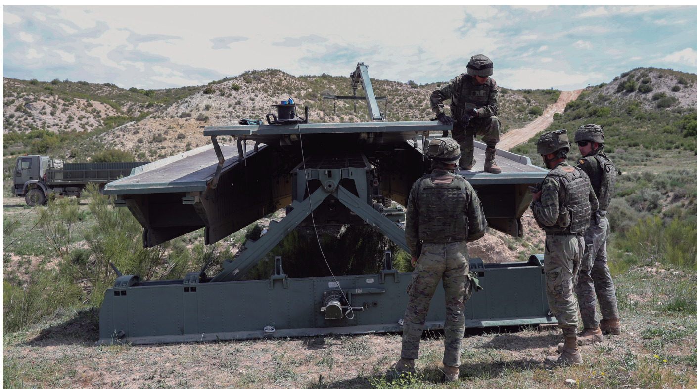
Zapadores de la sección de puentes de apoyo a vanguardia supervisan la instalación de la plataforma Dornier que permitirá salvar una cárcava de 21 metros de ancho y dos de profundidad y reabrir una ruta de abastecimiento.
