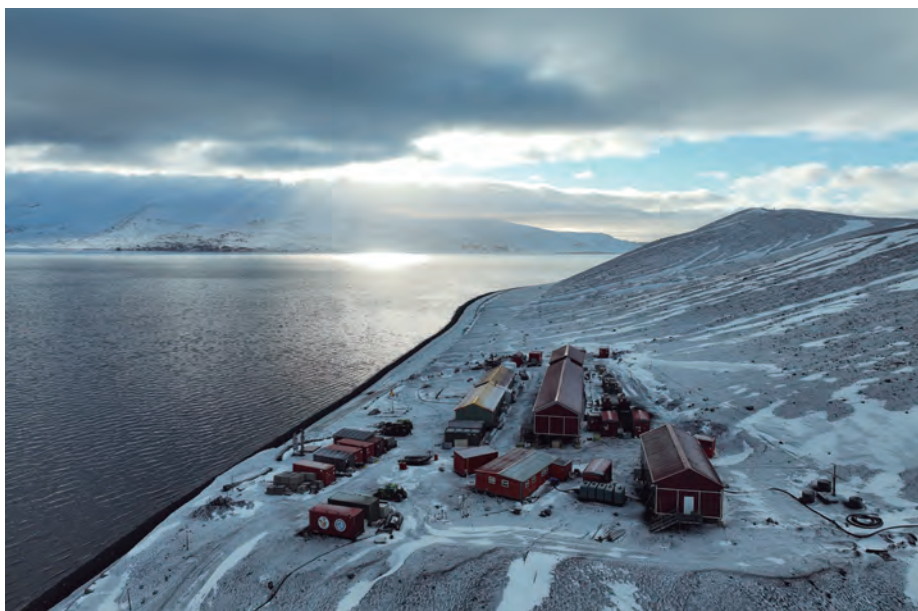
Vista aérea de la base Gabriel de Castilla , con el nuevo módulo científico que se ha construido durante la campaña antártica y que permitirá a los investigadores trabajar en mejores condiciones.
