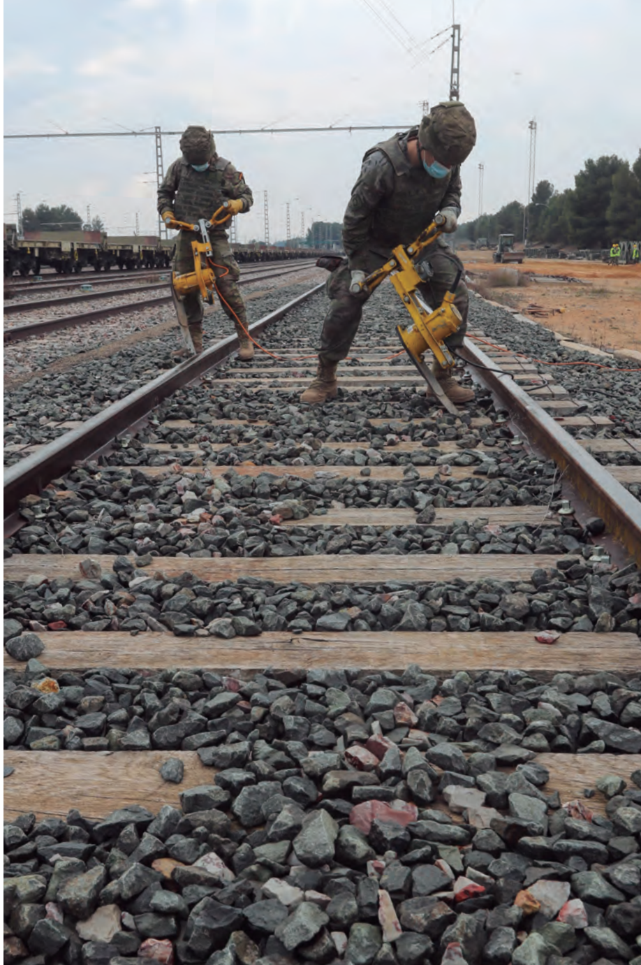
La sección de Vía y Obra se ocupa del mantenimiento o la construcción de nuevos tramos con sus equipos de nivelación y bateo (arriba) y de topografía (debajo).
