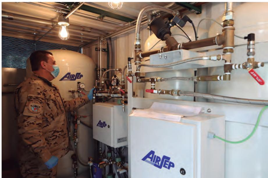
En el exterior del *Gómez Ulla*, la Unidad Médica de Apoyo al Despliegue Aéreo instaló un contenedor generador de oxígeno, con botellas de 50 litros, para cubrir las necesidades del hospital.
