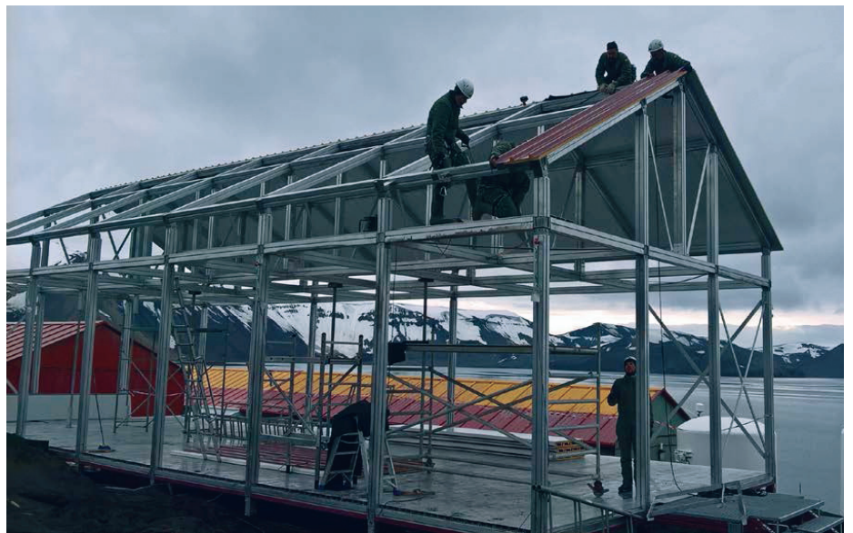
Arriba, construcción del almacén. Debajo, las rampas utilizadas este año para facilitar la subida y bajada del material desde la línea de costa a la base.
