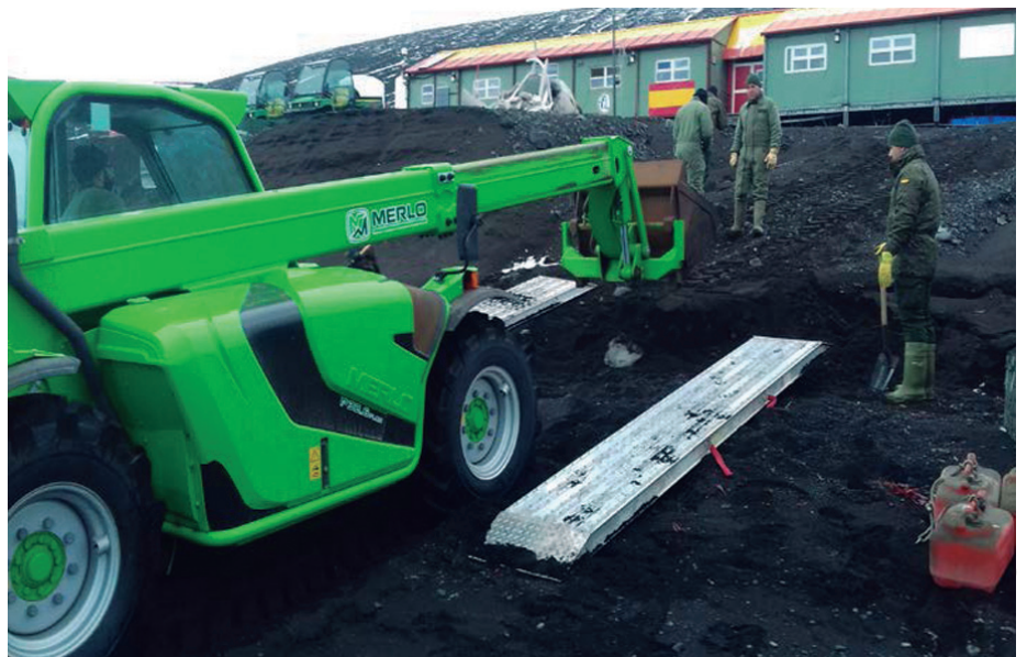
Arriba, construcción del almacén. Debajo, las rampas utilizadas este año para facilitar la subida y bajada del material desde la línea de costa a la base.
